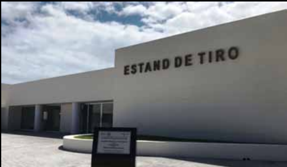
Fachada del edificio del Estand de Tiro.
